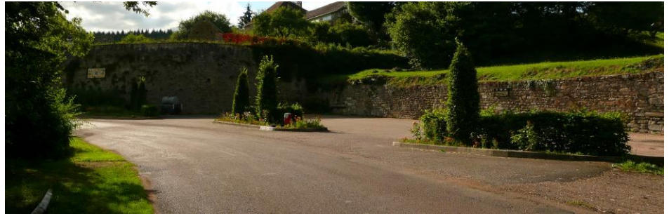
Espace de commémoration et de stationnement, RD 26
