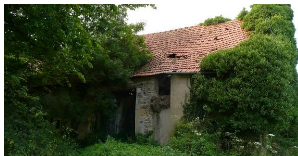
Maison à l'abandon, RD 11c
