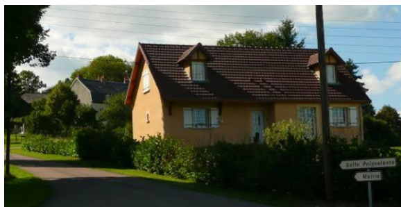
Habitation récente, au croisement de la rue de l'Eglise avec la RD 11c, Sud du bourg.
