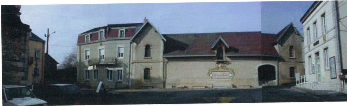
Place de l'Eglise, vue vers le domaine du Clos de Tart Des travaux en cours ont pour but de traiter davantage cet espace en place urbaine.
