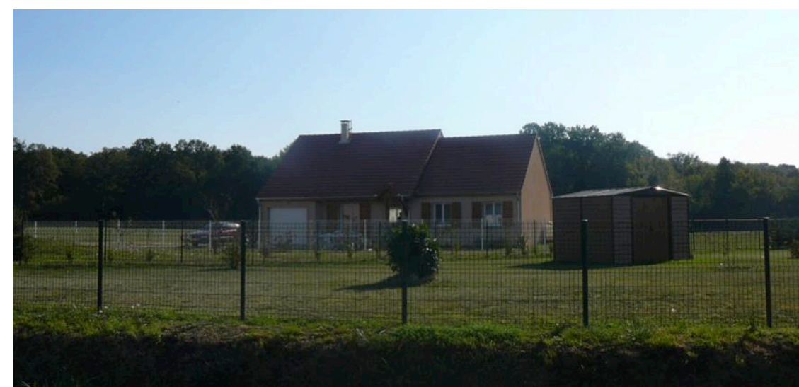
Exemple de bâti récent
