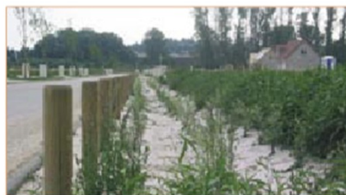
Une noue collectrice des eaux pluviales.
