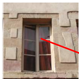
Surépaisseur et irrégularité des encadrements ou chaînages
