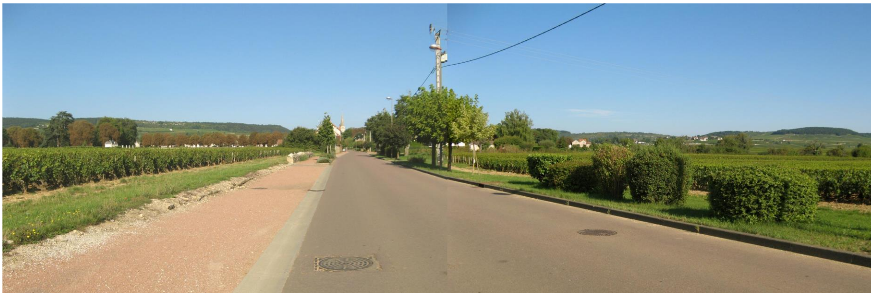
La D23, des plantations qui ne sont pas à l'échelle du site
