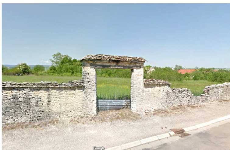
Le portique permettant l'accès au Clos Lambert est en bon état suite à une restauration.
