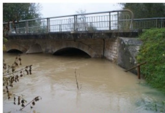
Station limni DREAL : pont sur la Vouge
