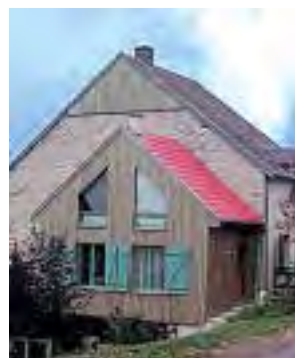
Percements en pignon
