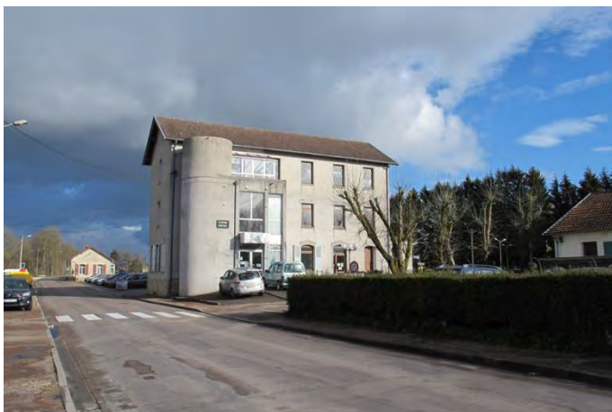
le bâtiment des associations
