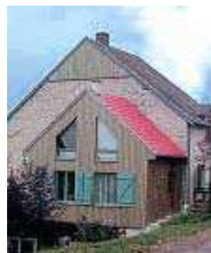
Percements en pignon
