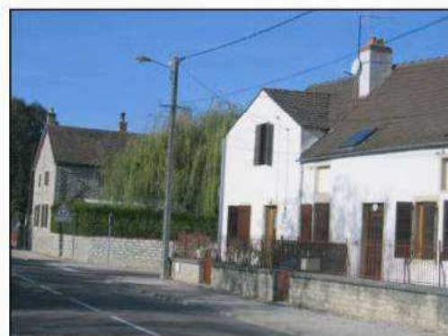
Extensions anciennes, rue du Chateau
