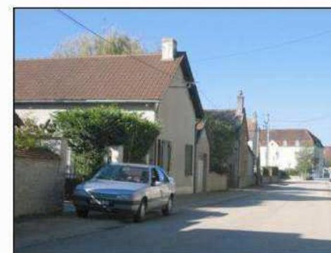
Extensions anciennes, rue du Moulin
