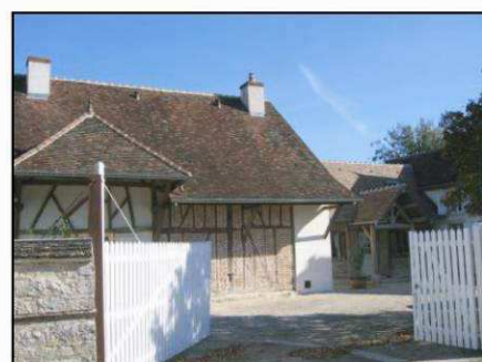
Corps de ferme, rue du Moulin
