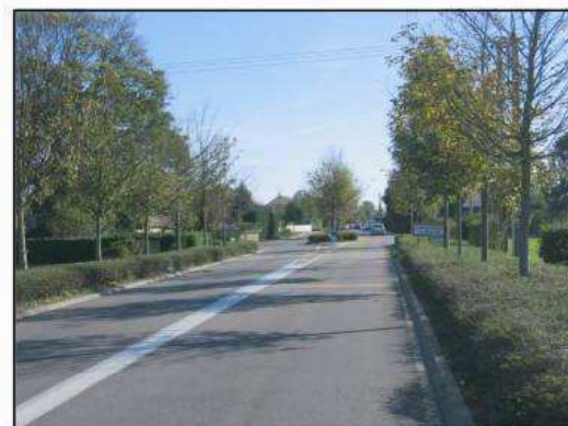
2 L'entrée dans le bourg depuis Thorey en Plaine, RD 968 Récemment aménagée, plantation et tourne à gauche sécurisée
