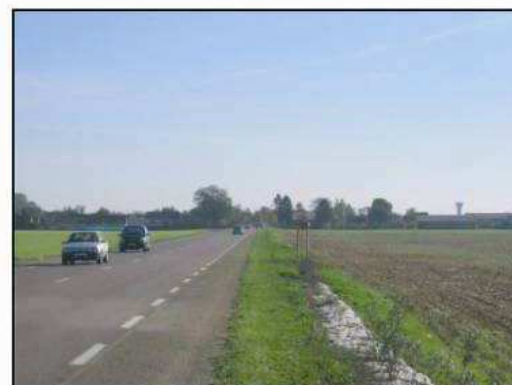
2 L'entrée de ville depuis Thorey en Plaine, RD 968 Le château d'eau d'Aizerey et les arrières du lotissement pavillonnaire marquent le paysage
