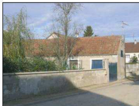
Extension ancienne à pignon sur rue, rue Meix Breisson
