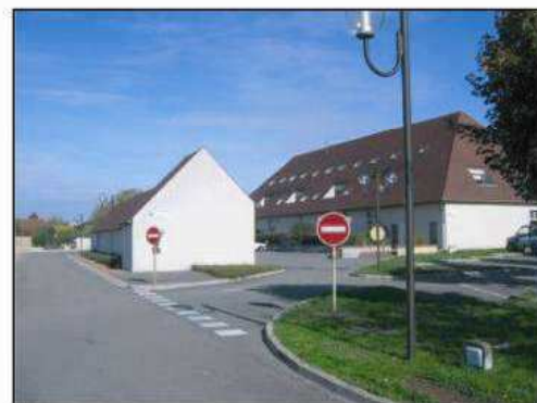
Extension récente, petit collectif rue des Sprendlingen
