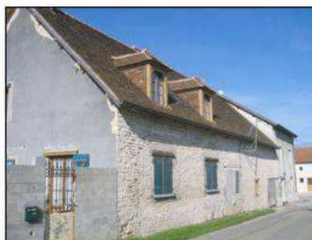
Extension ancienne rénovée, ruelle du Murot
