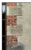
Différents appareillages de briques, droits et en harpage*, en association avec de la pierre.
