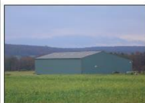
Bardage en tôle grise.
