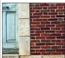
Différents appareillages de briques, droits et en harpage*, en association avec de la pierre.
