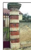
Différents appareillages de briques, droits et en harpage*, en association avec de la pierre.
