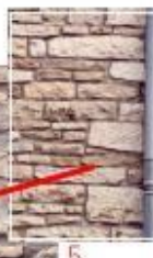
Mise au jour des pierres et rejointoiement au mortier de ciment. Joints en retrait ou en saillie
