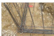
Nœud de chaînage - Continuité mécanique
