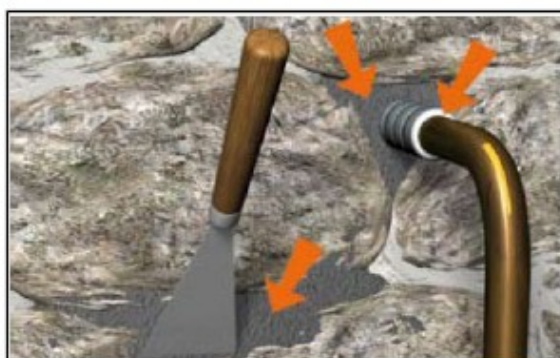
Situation après travaux de colmatage
