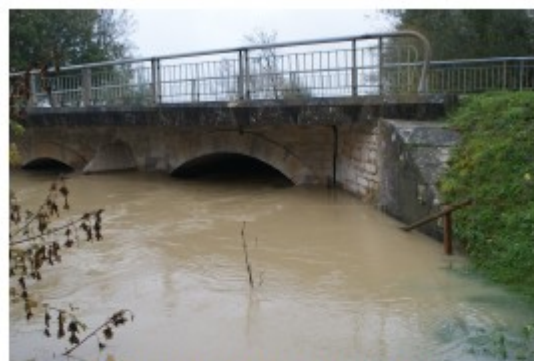
Station limni DREAL : pont sur la Vouge
