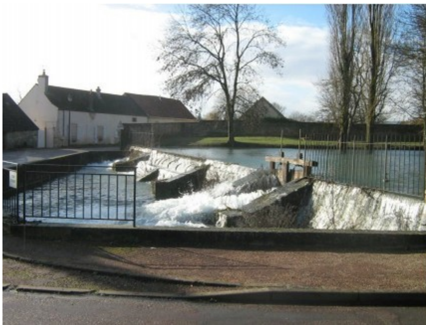
Illustration 9: Seuil de la Vouge à l'aval du château de Gilly - source étude BRLi
