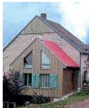
Percements en pignon
