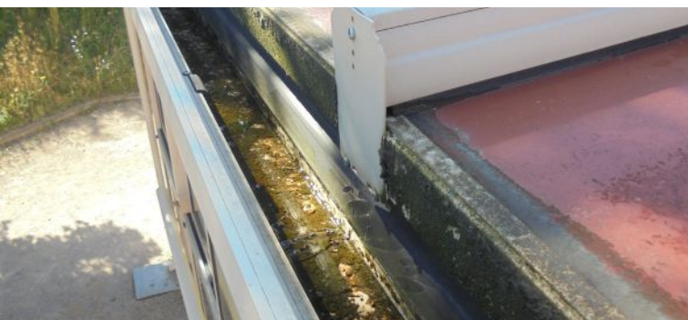
Exemple de chéneaux bouchés créant des gîtes larvaires propices au développement du moustique-tigre
