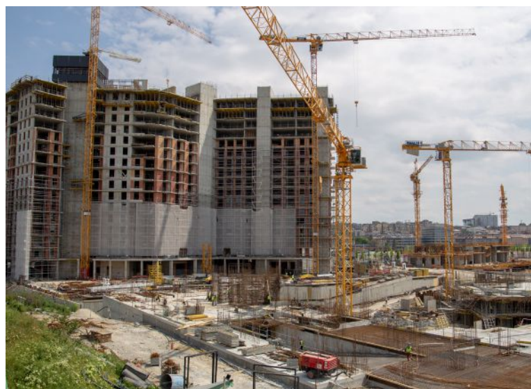
Chantier de construction
