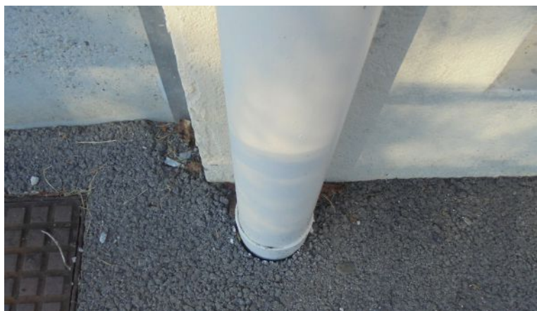
Exemple d'une descente de cheneau hermétique
