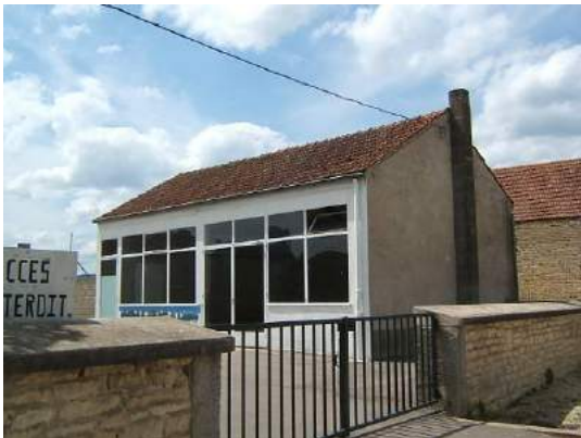
L'école – bâtiment arrière sur cour
