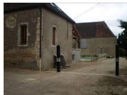
Ancienne ferme chemin des Curtils
