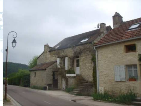
Constructions traditionnelles rénovées Source Topos
