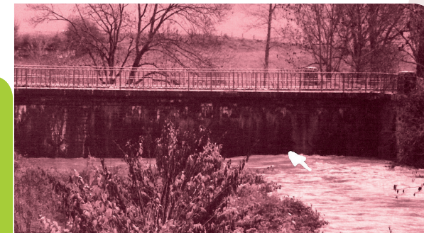
Crue de 2001, pont-canal à Pont d'Ouche
