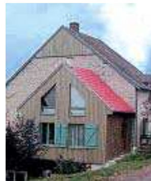
Percements en pignon
