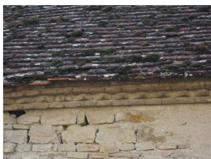
corniche en appareillage de brique
