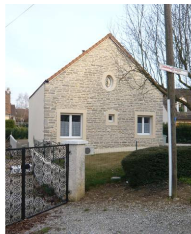
façade principale sur pignon
