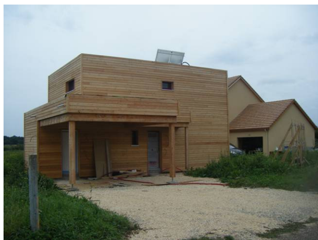
à toit terrasse, structure et façade en bois
