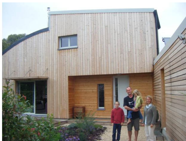
à structure et façade en bois et acier
