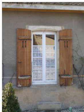
linteau pierre en arc surbaissée
