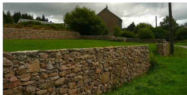
Présence de nombreux murs en pierres
