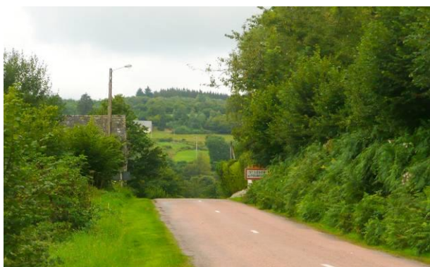
Entrée Sud sur le hameau depuis la RD 106
