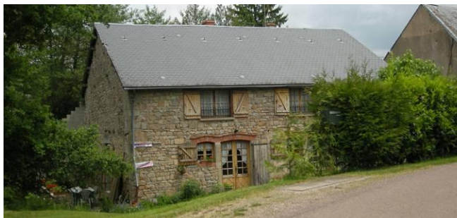
Exemple de bâti ancien sur le bourg
