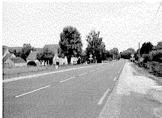
Section rectiligne de la RD 971 au droit du site étudié
