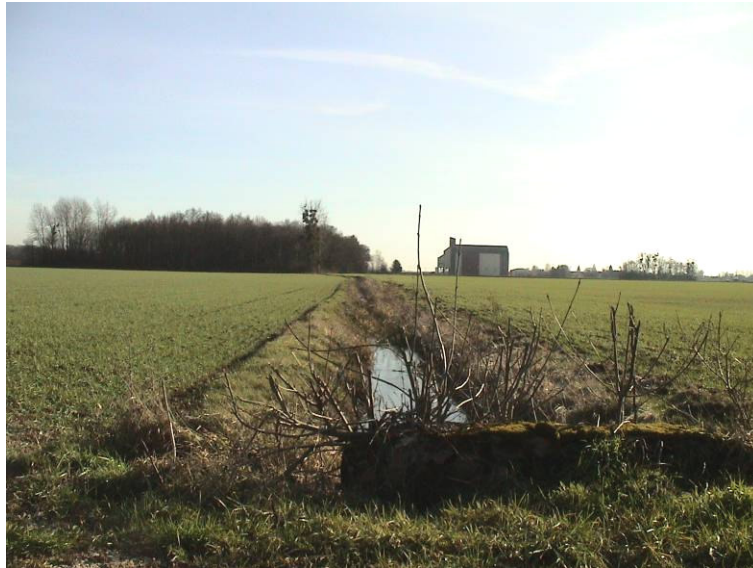
Fossé traversant le chemin des Rodots, en direction du silo
