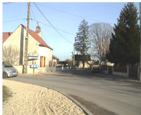
Virage de la rue de la Louve, carrefour avec la rue de la Forge
