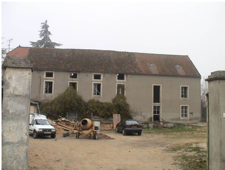
Moulin (en cours de réhabilitation), rue du lavoir
