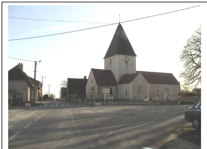
L'église vue de la place du centre
