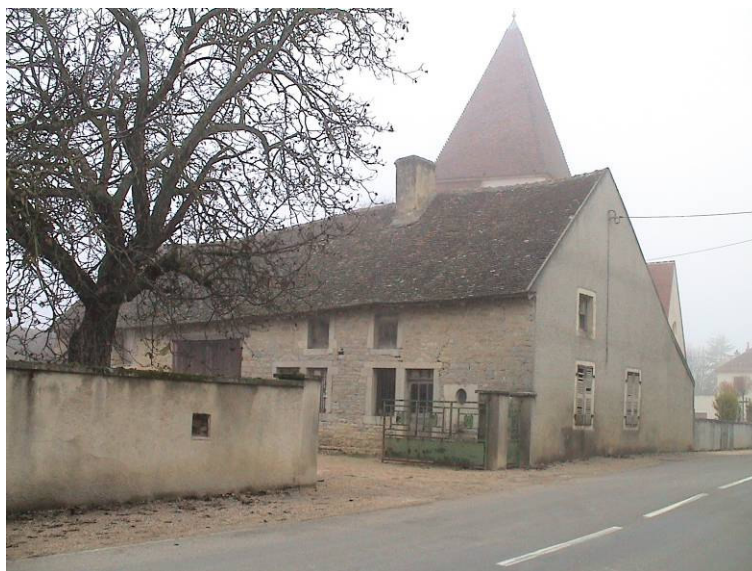
Grange partiellement aménagée en habitation, rue de la Louve
