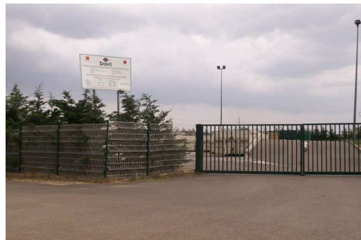
La déchetterie, isolée du reste de la zone
