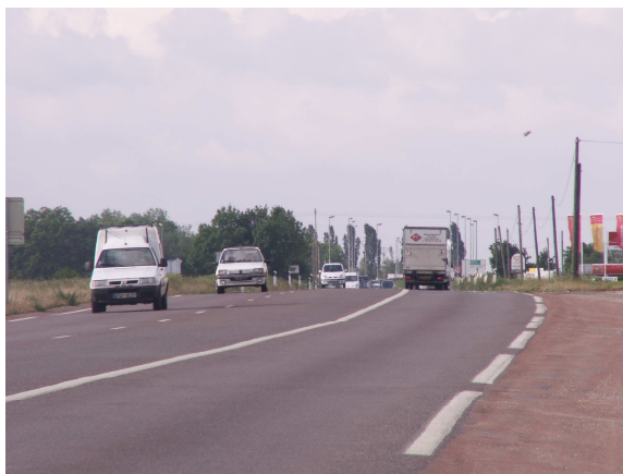
L'emprise et le trafic important de la RD974 constituent une barrière physique importante
