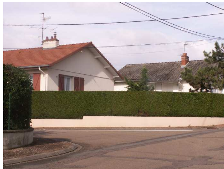
disparité de toitures dans la zone d'extensions récentes
