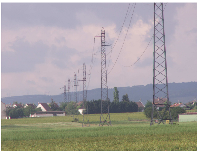
Réseau électrique jalonnant les territoires communaux
