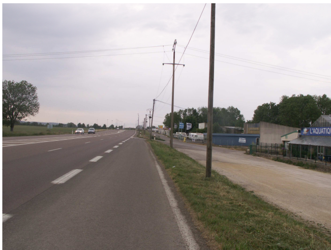
RD974 et réseau électrique aérien entre Brochon et Fixin
