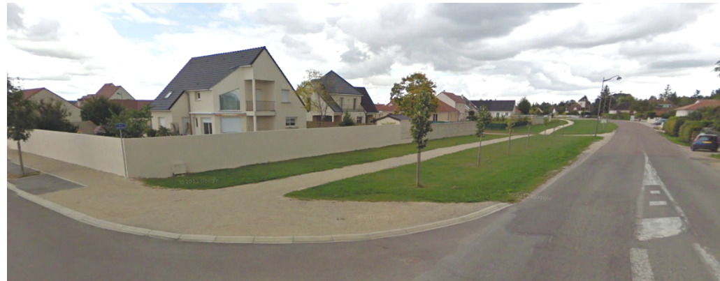
Aménagements à l'entrée du lotissement "Les Faucilles"
