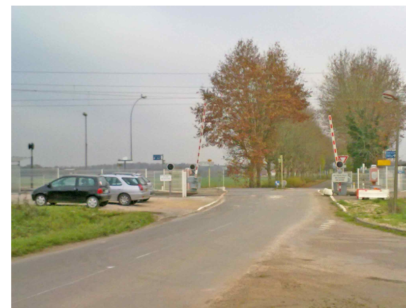
Halte ferroviaire de Brétigny
