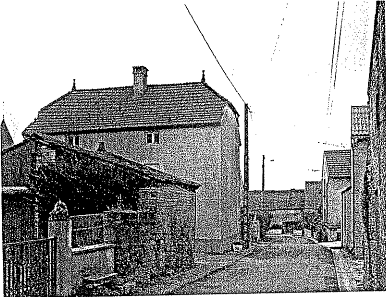
Ancien couvent, rue des Cours
