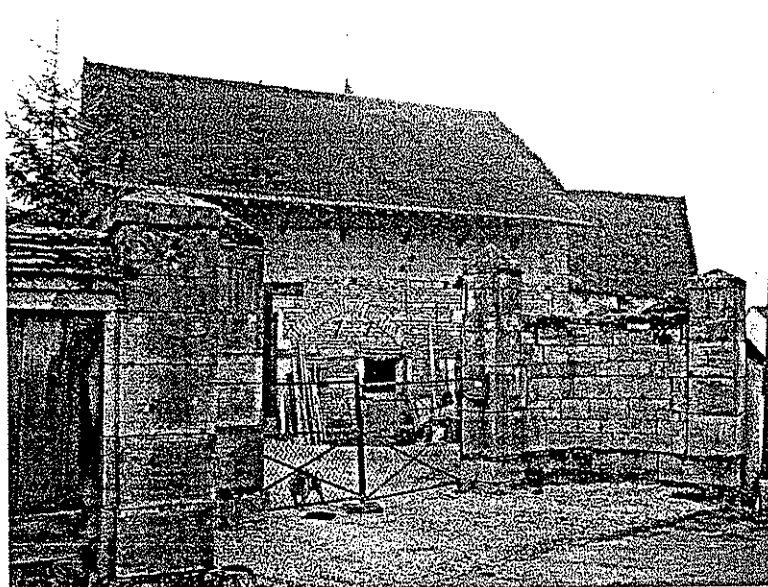
Une entrée de cours avec piliers, rue des Cours
