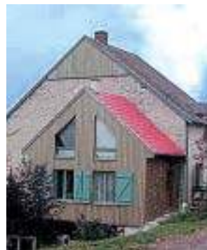
Percements en pignon
