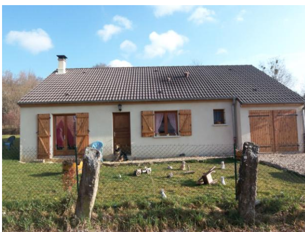
Nouvelles constructions – Photo BLC février 2008
