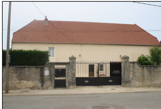
Maison ancienne rénovée
