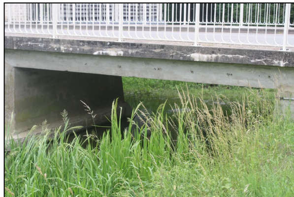
Le Crosne, élément structurant de la trame bleue locale
