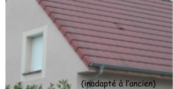
Volumes et matériaux propres aux bâtiments agricoles
