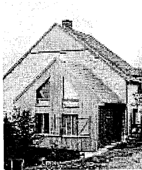
Percements en pignon
