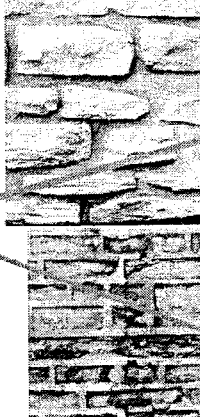
Mise au jour des pierres et rejointoiement au mortier de ciment. Joints en retrait ou en saillie
