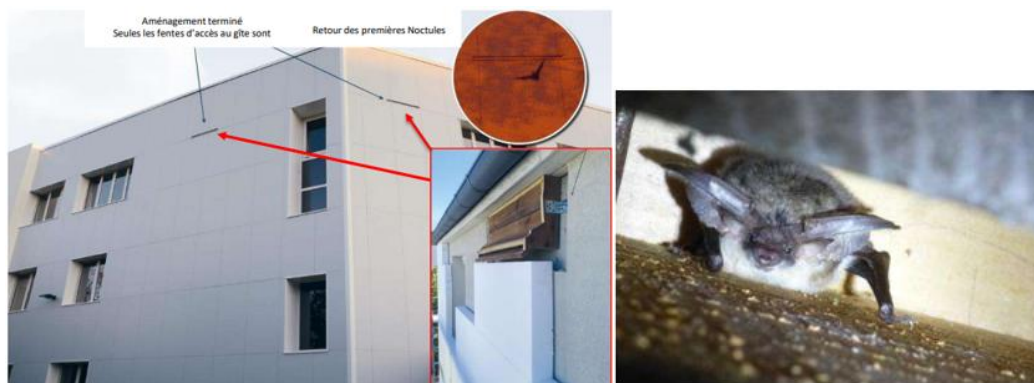
Aménagement en façade d'un gîte à noctule (à gauche) et Oreillage gris dans un gîte artificiel (à droite)
