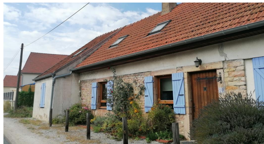
Réhabilitation qualitative d'une longère à Auxonne
