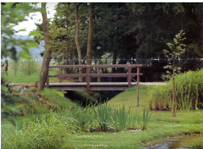
Exemple d'intégration du traitement des eaux de pluie dans un ensemble paysager.
