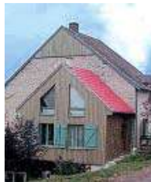
Percements en pignon
