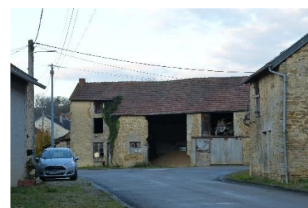
Bâtiment vacant à reconstruire
