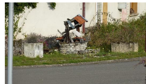
Puits à réaménagé
