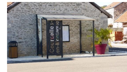
Réaménagement du centre du village – abris bus
