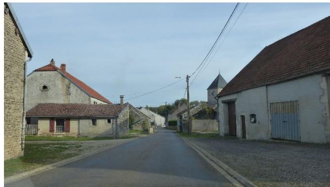
Rue Haute centre village rue, pierres et vue sur l'église
