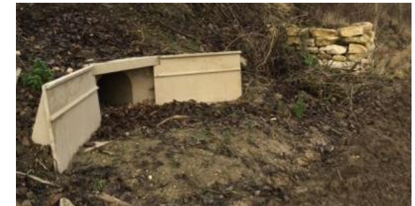
Exemple de passage à faune souterrain – source : IASEF
