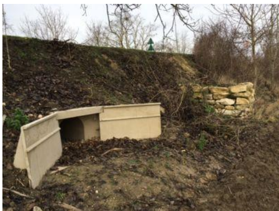
Exemple de passage à faune souterrain – source : IASEF
