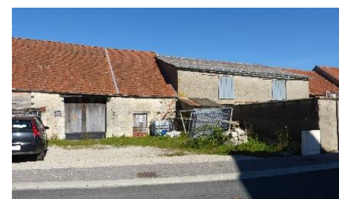
Éléments marquant négativement le village (mur non enduit)
