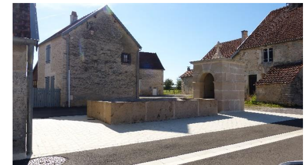
Lavoir rénové et espace public réaménagé
