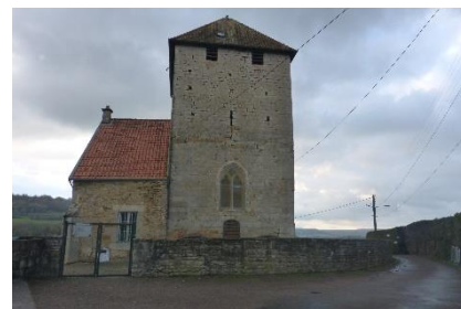
Eglise et mur d'enceinte rue du Paradis
