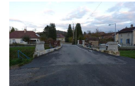
Pont en pierres sur la Marne
