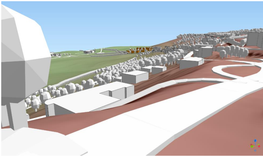
Vue des constructions depuis le croisement RN 19 – Rue des Marronniers au pied de la citadelle
