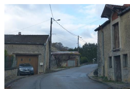
Bâtiment vacant à reconstruire
