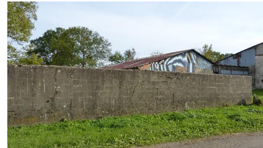
Éléments marquant négativement le village (entrée nord)
