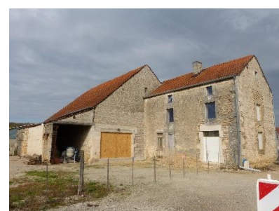
Bâtiment vacant à potentiel intéressant
