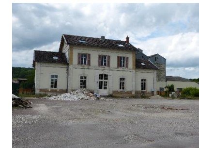
Gare de Rolampont
