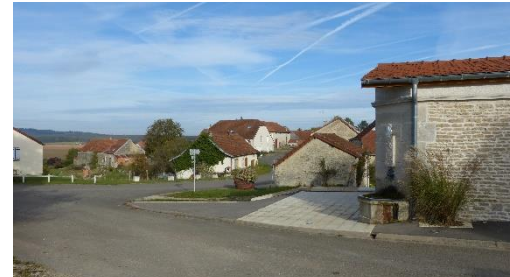
Lavoir et espace public aménagé
