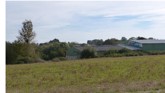
Bâtiment agricole en entrée nord
