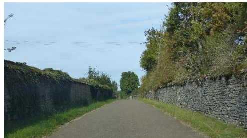
Murs encadrant la route du château
