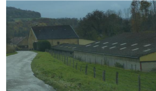
Éléments marquant négativement le village (entrée nord)
