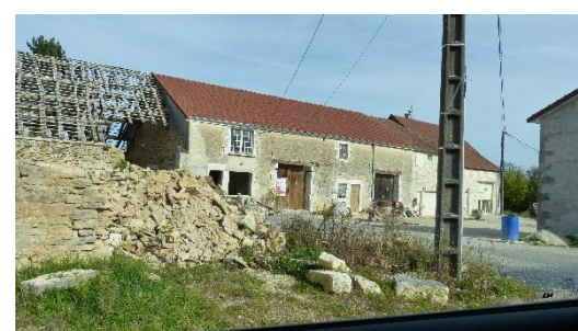
Bâtiment en cours de réhabilitation
