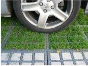
Dalle alvéolaire (béton ou plastique) - Source : Sol-aire
