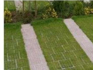
Solution mixte dalles alvéolaire/ pavés Source : Sol-aire
