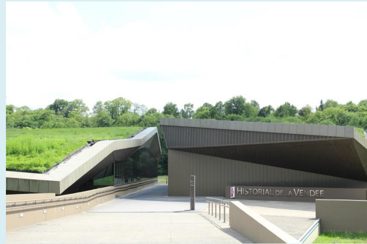
L'historial aux Lucs sur Boulogne (toiture végétale, architecture qui épouse le paysage arboré des alentours)
