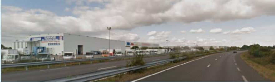
La 2*2 voies à hauteur de Bellevigny qui traverse l'Est de la Communauté de Communes en direction de Nantes et de la Roche-Sur-Yon.
