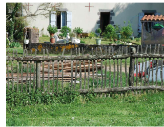
Ganivelle renforcée par des lisses horizontales en demi-rondins fraisés. La durée de vie d'une telle barrière est estimée à une dizaine d'années sans traitement particulier; Oradour-Fanais
