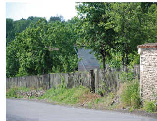
Ganivelle d'échalats fendus mécaniquement. Le bois grise naturellement et s'intègre parfaitement au paysage rural boisé; Cellefrouin
