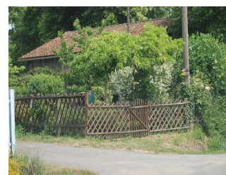
Barrière croisée, renforcée par des lisses horizontales en demi-rondins fraisés; Saulgond
