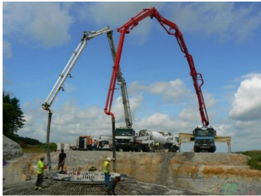
Figure 26 de ferrailage et coulage des fondations
