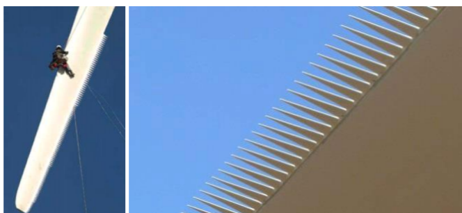
Figure 18 de pale dotée d'un système STE (peigne/dentelure) (photographies)
