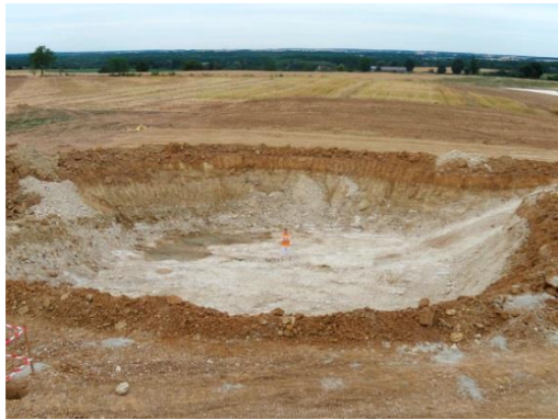
Figure 25 exemple de fondation excavée et remblais
