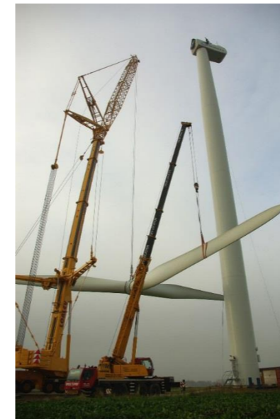
Figure 28 d'exemple de séquences d'assemblage d'une éolienne
