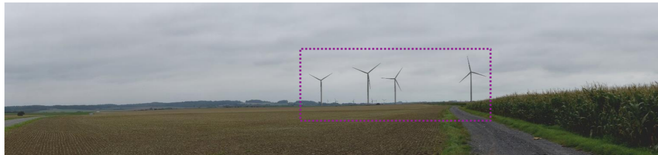
Figure 162 de la vue depuis la sortie nord de Lesquielles (photomontage du projet, point de vue 1)
