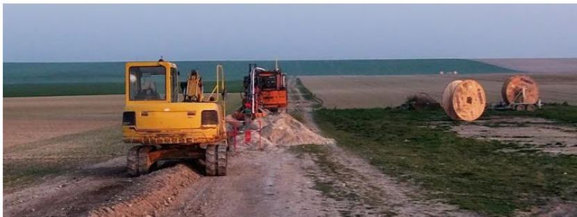
Figure 27 d'un exemple de travaux pour l'installation du raccordement enterré
