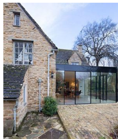
Toiture terrasse sur volume annexe
