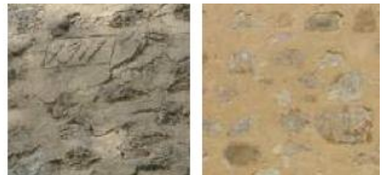
Enduit à pierre vue
