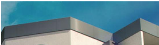
Bandeau sur acrotère de traitement différent de la façade
