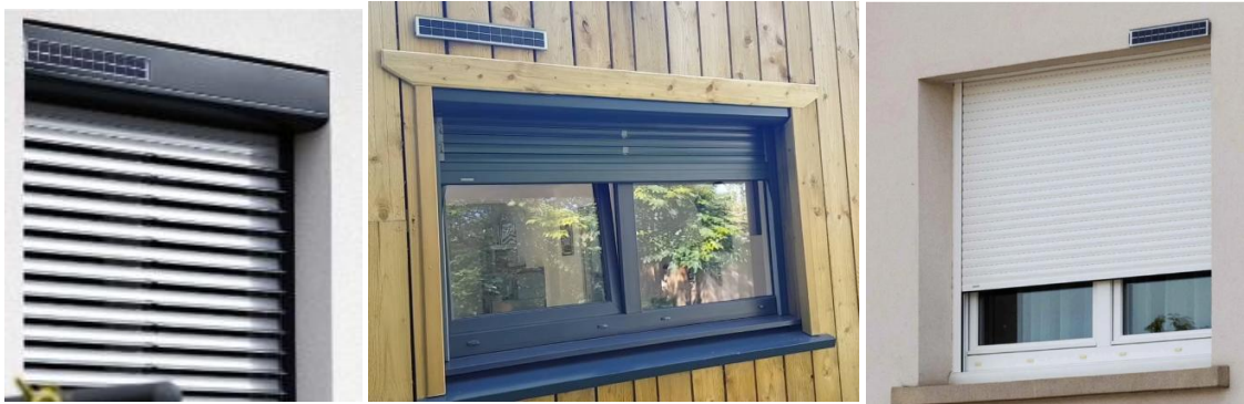
Illustration de type d'insertion non saillante des volets roulants à mettre en œuvre
