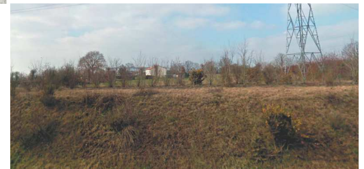
6. Pylone de ligne à haute tension
