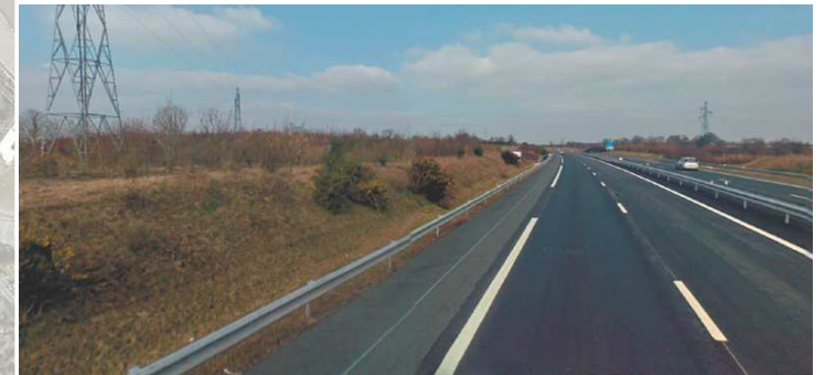
5. Talus et autoroute A87
