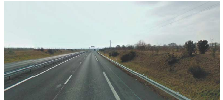
4. Talus et autoroute A87
