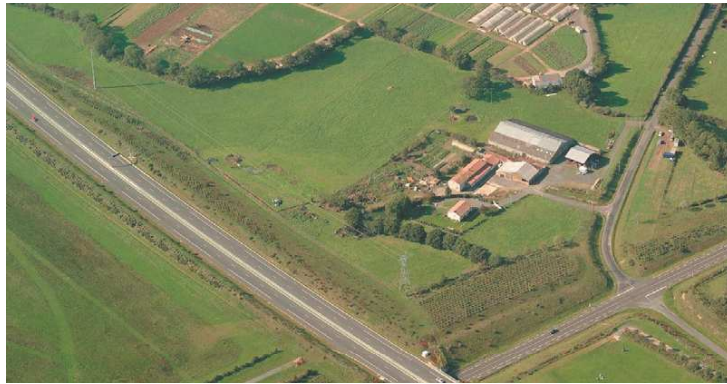
1. vue générale du site de projet
