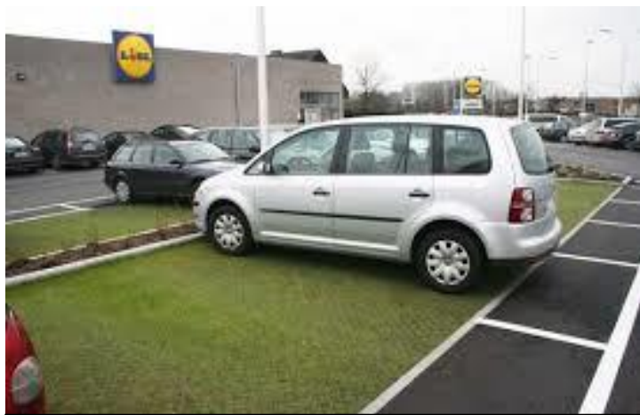
Exemple de stationnement végétalisé
