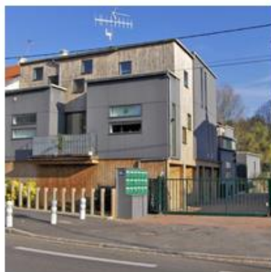
Nantes : la Beaujoire (44) Architecte : In Situ, Pierrick Beillevaire
