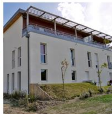
Bouguenais : la Grande Ouche (44) Architecte : inconnu
