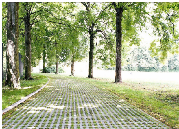
Revêtement de circulation douce semi-perméable
