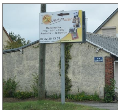
Publicité scellée au sol non conforme
