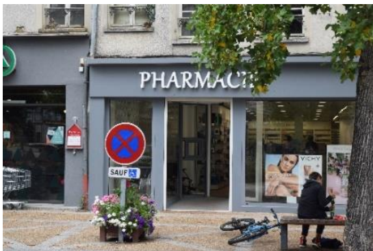
Enseigne en façade en lettres découpées
