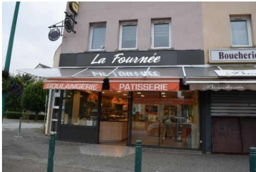
Enseigne de façade non conforme malgré son caractère relativement qualitatif
