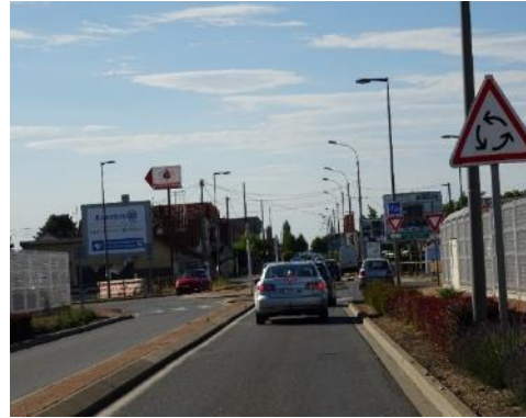
Domérat : entrée d'agglomération brouillée par une succession d'éléments verticaux
